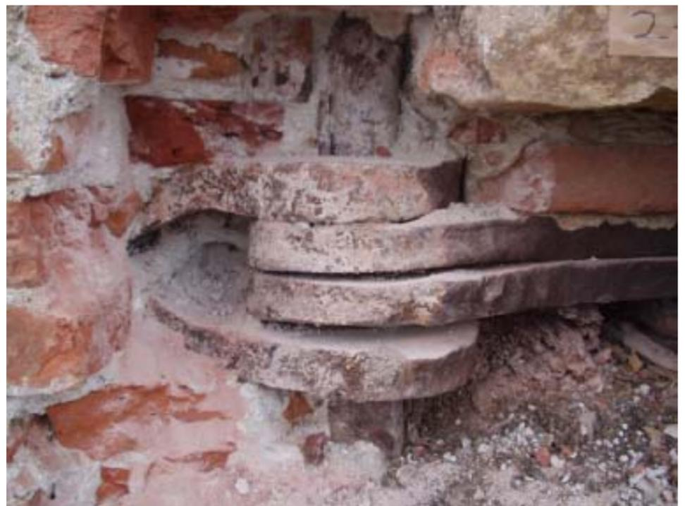
補強リングの継手部分
