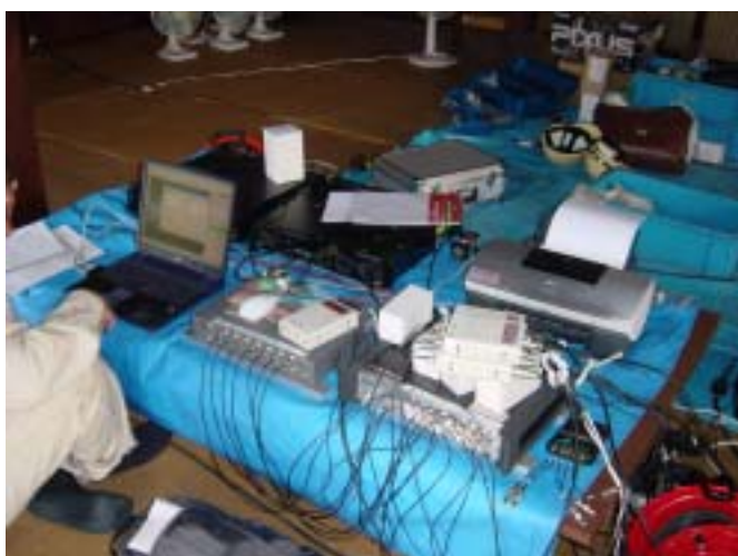
電力増幅器、データロガー
